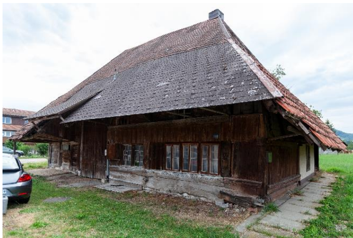
Abb. 1 Aussenansicht des dokumentierten Bauernhauses. (Foto: K. Diggelmann)
