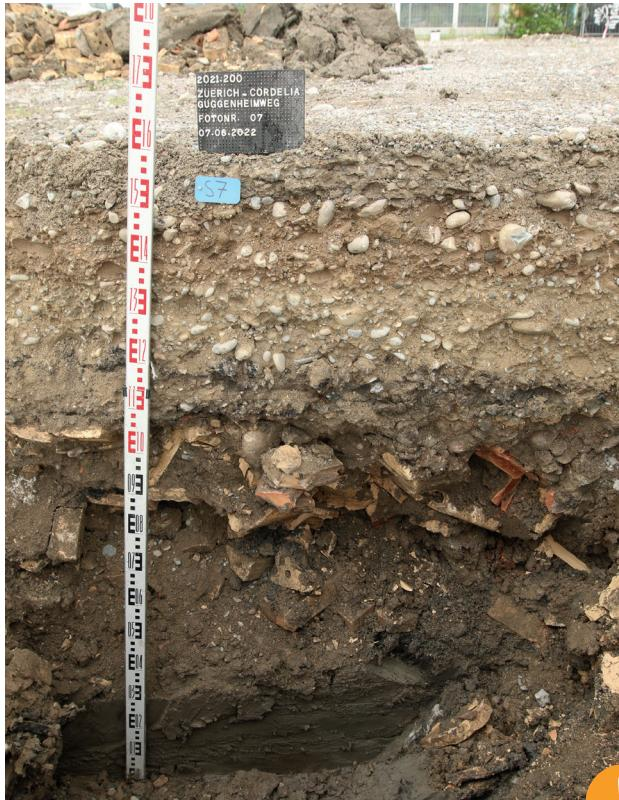
Sondiergraben ist trocken, Aushubdepot mit ausreichend Abstand zum Graben, Tiefe rund 1.5 m: kurzer Aufenthalt zur Aufnahme möglich.
