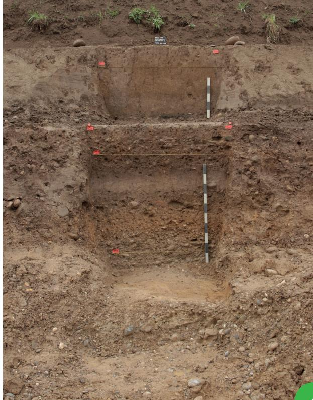
Abtreppung an Hängen oder in Baugrubenböschung mit Bermen verbessert die Standfestigkeit und dient der Vermeidung grosser Wandhöhen (idealerweise Wandhöhe frontal und seitlich < 1.5 m)
