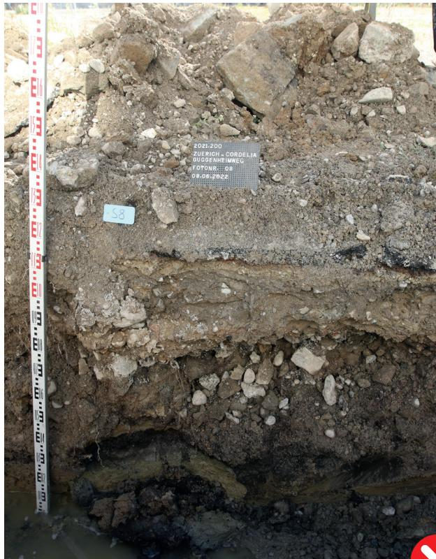
Aushubdepot zu nahe an Böschungs-oberkante, Wasser auf Sohle, rollige Schicht im unteren Teil des Grabens (leicht unterhöhlt): Trotz geringer Tiefe nicht begehen! Spontaner Einbruch der Schachtwand ohne Voranzeichen möglich.
