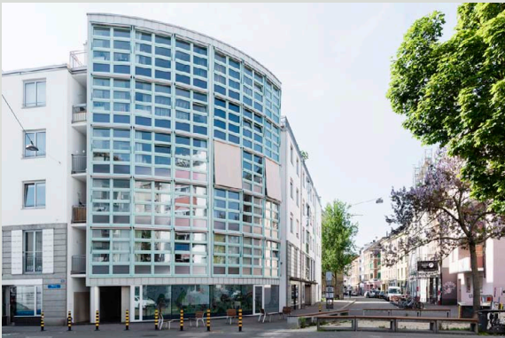
Abb. 3: Diener & Diener, Wohnüberbauung Hammerstrasse, Basel BS, 1978–1981. © Noah Santer, Schweizer Heimatschutz
