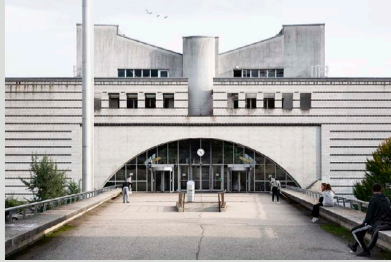
Abb. 5: Vincent Mangeat, Gymnase cantonal, Nyon VD, 1984–1988. © Noah Santer, Schweizer Heimatschutz
